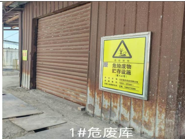
图 3-1 企业现有危废库（1#）现场情况
