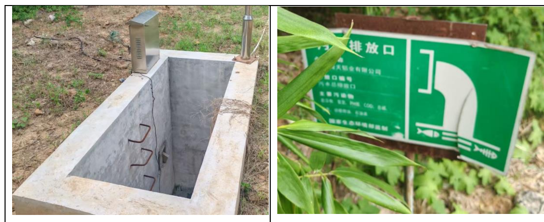
图 3-3 本项目废水排口及标识牌
