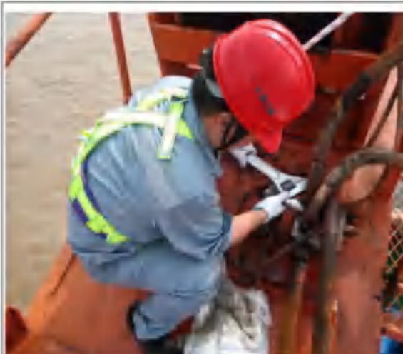
吊机液压管检查、紧固
