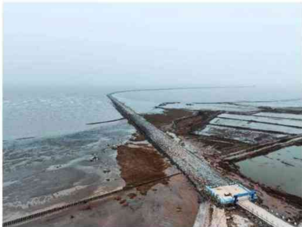
图 4.1-16 防波堤现状航拍图
