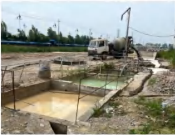
图 4.1-3 预制场生产废水沉淀后洒水抑尘
