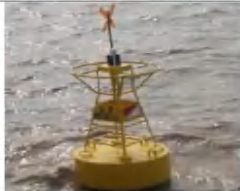
图 4.1-9 施工海域施工警示灯
