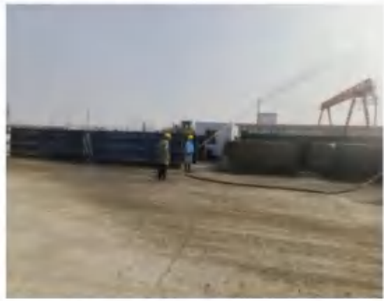
图 4.1-3 预制场生产废水沉淀后洒水抑尘
