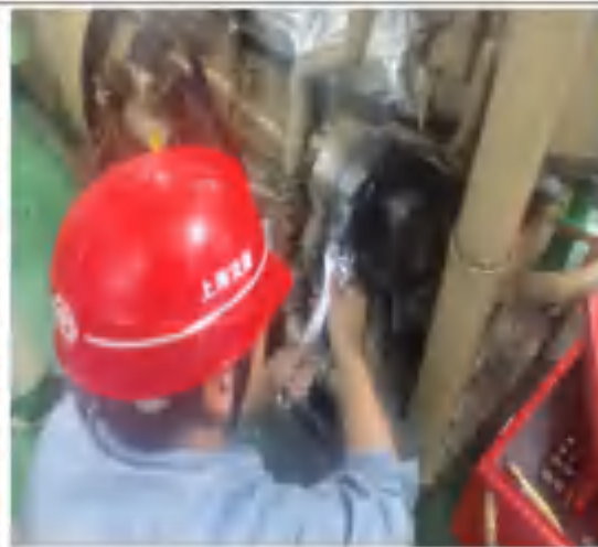
主机皮带更换
