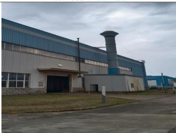
二期抛丸废气排气筒
