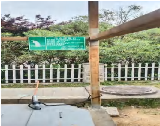
一期污水排口
